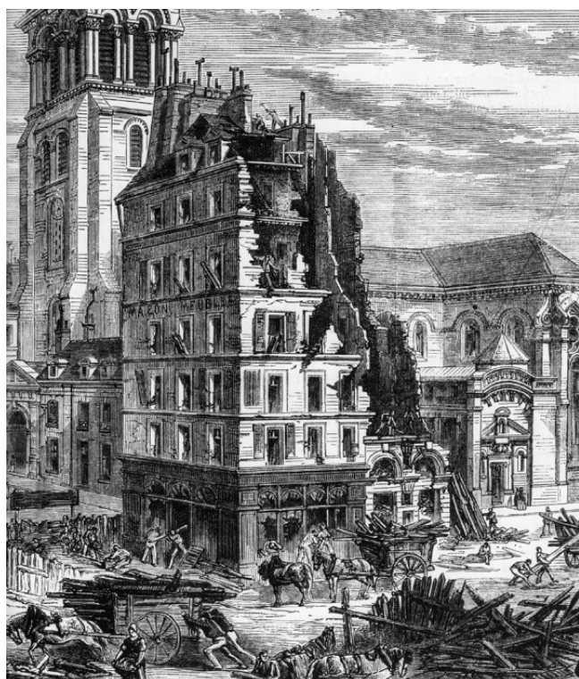
La démolition des rues voisines de l'église et de la place en vue des percements de la rue de Rennes. Dessin de Delannoy (Doc. C Chevalier).
