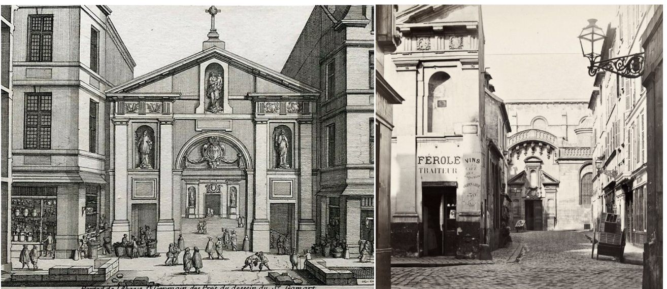
À gauche, la porta major , gravure de Marot, d'après un dessin de Gamart (Doc. SH6). À droite, la même porte amputée de sa partie droite, photographie de Charles Marville, c. 1867, prise de la rue des Ciseaux (source Vergue). On y repère la rue Gozlin/Sainte-Marguerite (traversante), la rue d'Erfurth (dans l'axe), et la porte Sainte-Marguerite de l'église (au fond).
